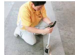
清掃インスペクション(汚染度計使用)
