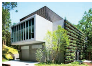
技術研修センター「実」全景
