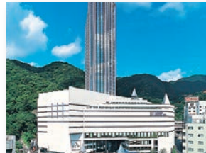
新神戸オリエンタルシティ・C3ビル
