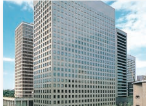
大手センタービル
