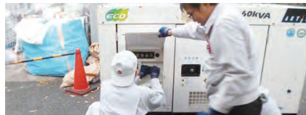
非常用発電機設置訓練
