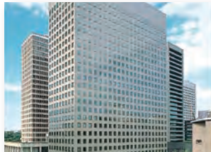
大手センタービル
