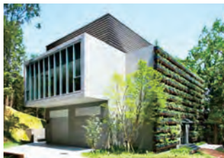
技術研修センター「実」全景
