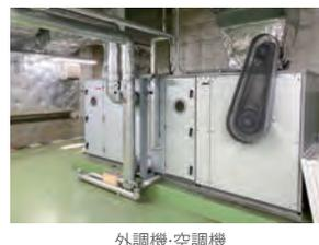
検討事項①：過剰供給の緩和 ⇒ 過剰供給と思われる既設制御を負荷に応じ圧力を変化させる比例制御方式に変更
