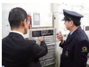
警備インスペクション (消防設備操作状況の確認)
