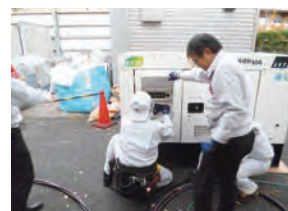
非常用発電機設置訓練
