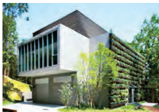
技術研修センター「実」全景
