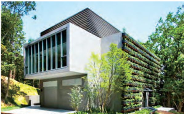
技術研修センター「実」全景
