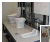
配管詰り・ 撤去訓練
